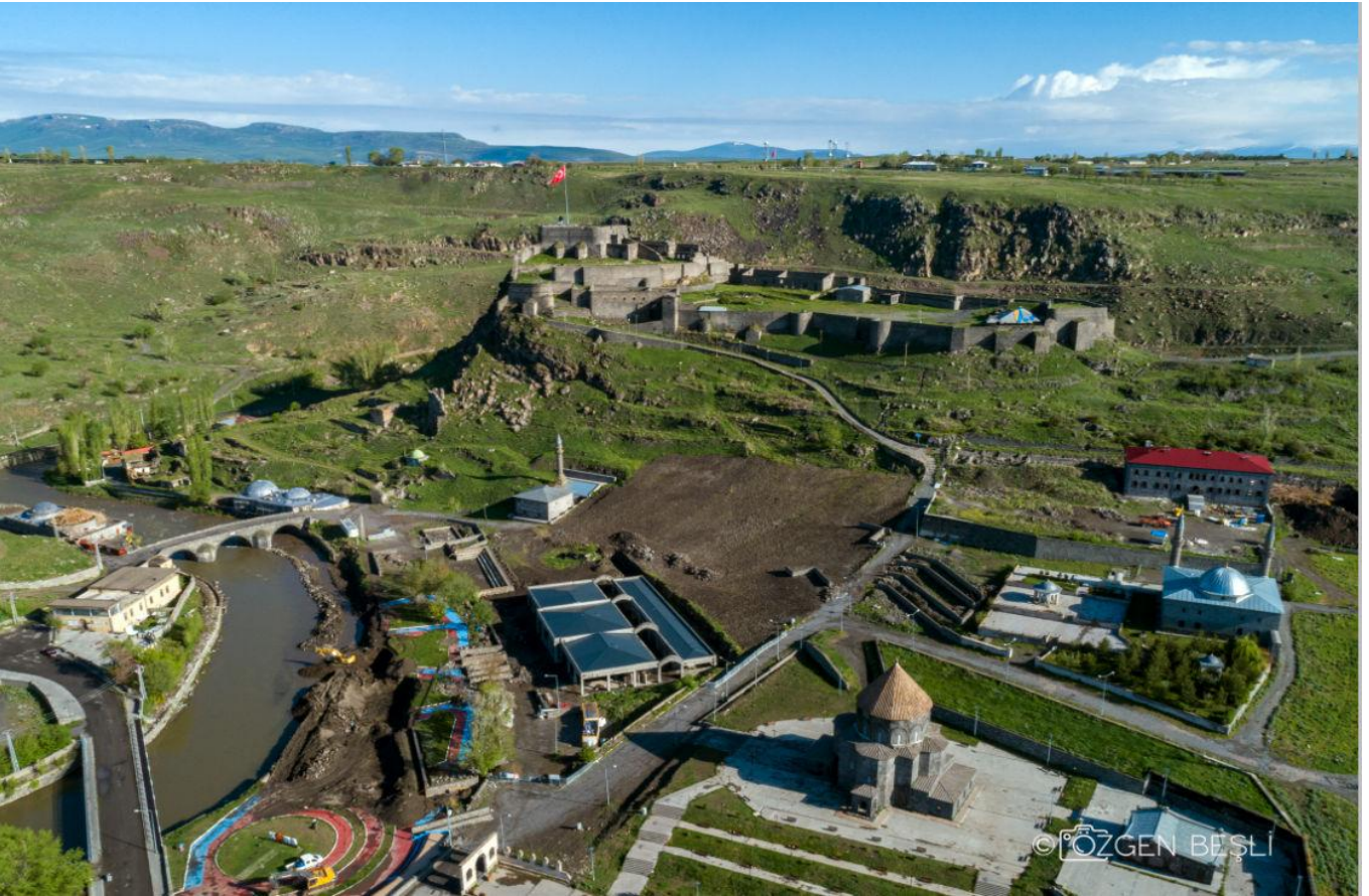
Resim. Kale ve etrafının yeni çevre düzenlemesi (Ö. Beşli 'den)
